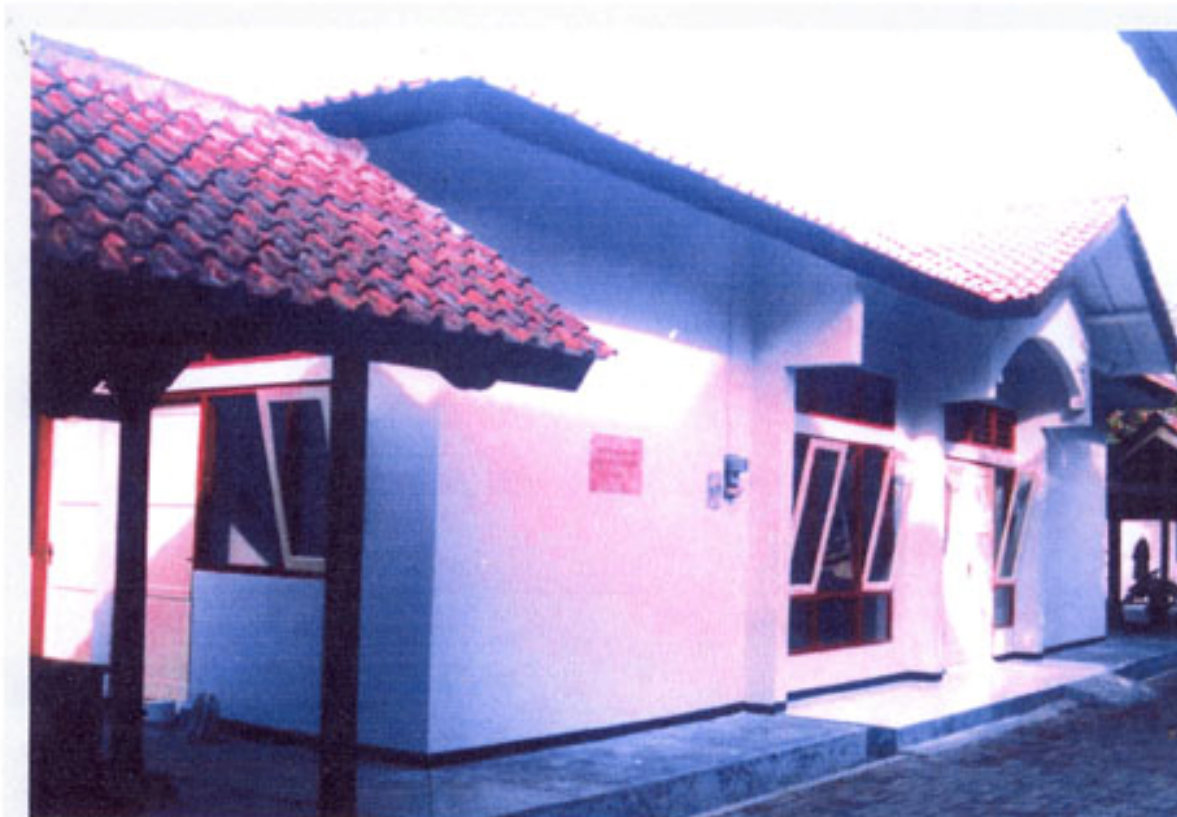
Kondisi 100% Bangunan Wisma
