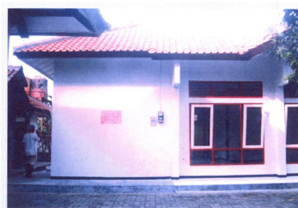
Kondisi 100% Bangunan Wisma
