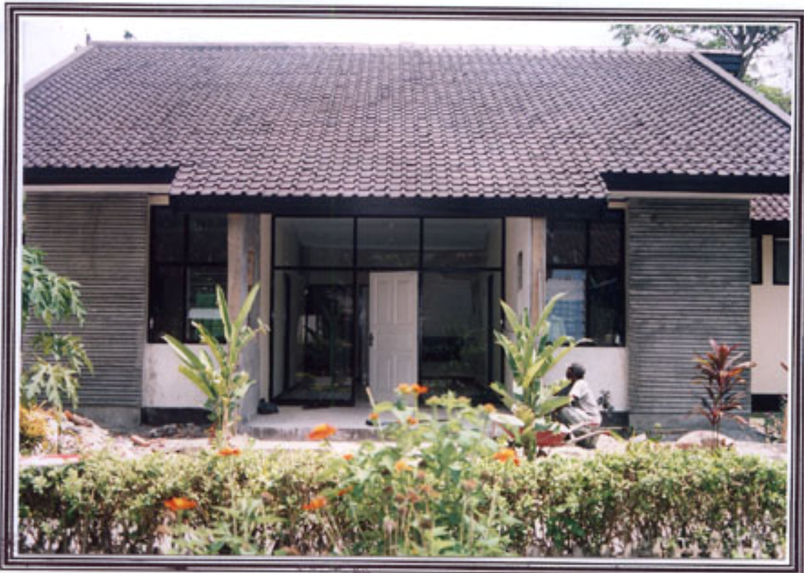
RENOVASI WISMA ( TAMPAK DEPAN )
